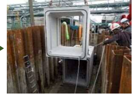
[マンホール設置工事]
