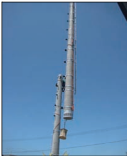
ハイボール継柱工事
