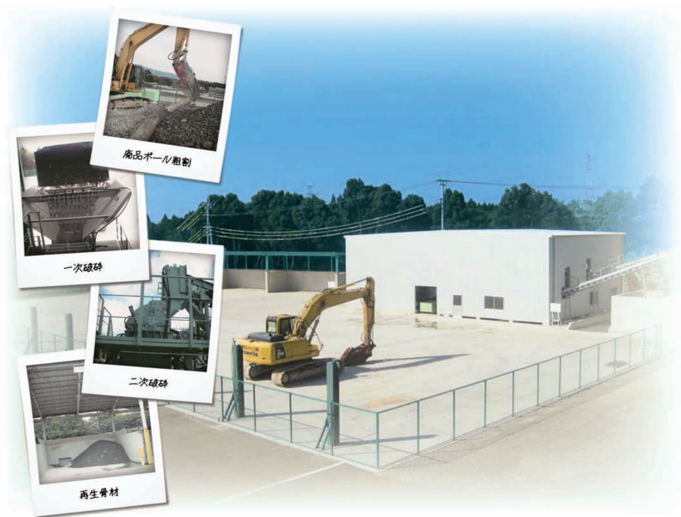
再生骨材プラント（熊本工場）
