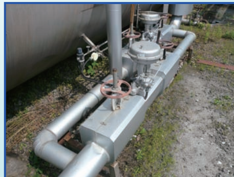
蒸気配管保温
