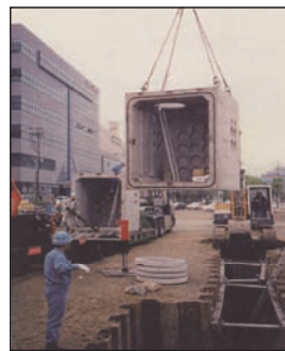
地中製品関係工事
