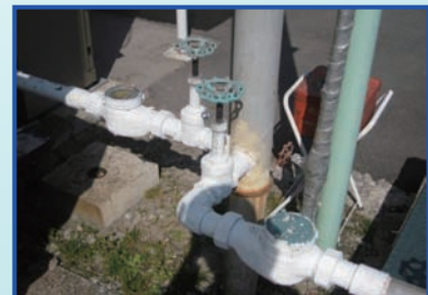
事務所方面の子メーター
