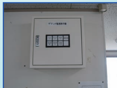
デマンド監視表示板
