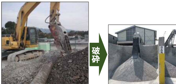
[廃品ポールの破碎処理]
