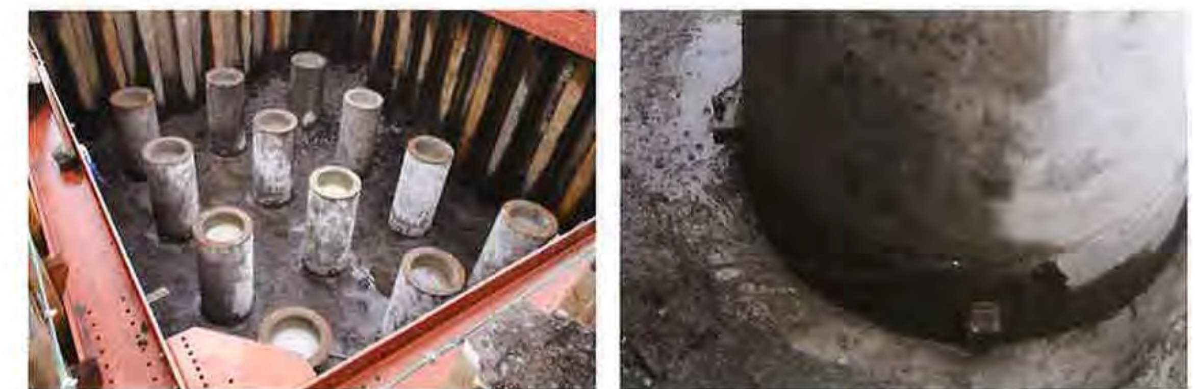
施工後の杭頭部掘削状況
