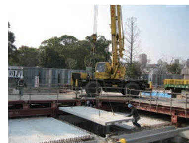
6 プレキャストスラブ材の布設
