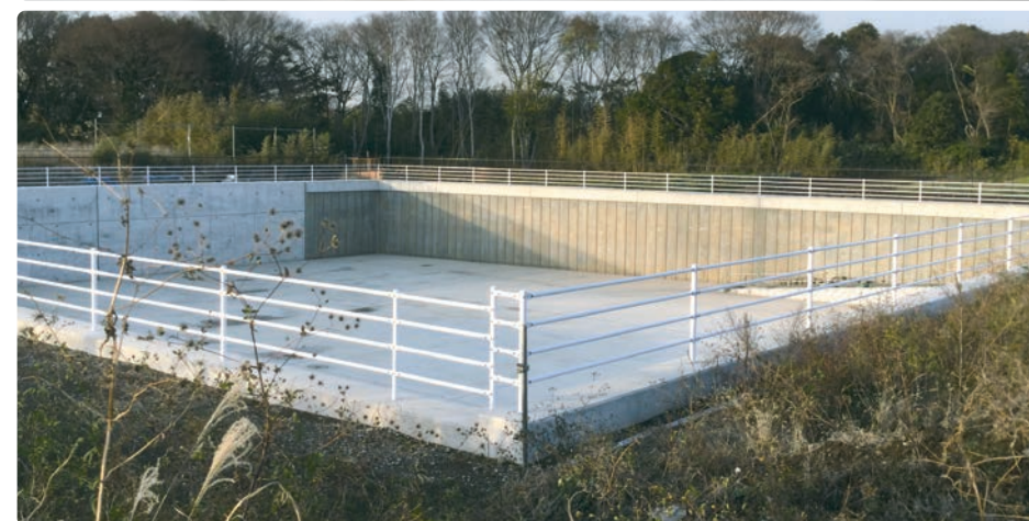
2 PC-壁体施工完了
