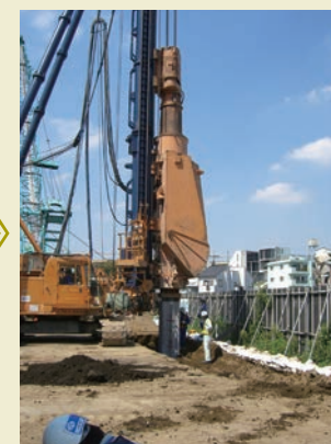
上部材の沈設
