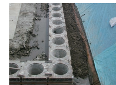
2 PC-壁体施工完了
