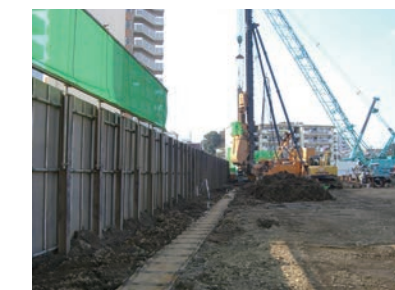
1 PC-壁体・中柱の施工
