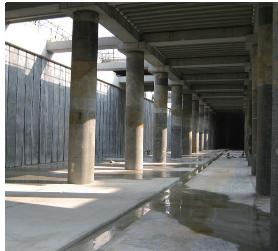
1 PC-壁体・中柱の施工
