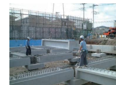
3 プレキャスト梁部材の設置
