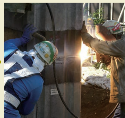
上部材の建込み・継手溶接
