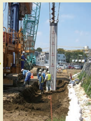
下部材の建込み
