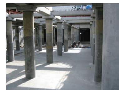
5 底版コンクリート打設
