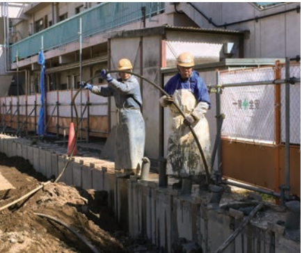
モルタル注入
