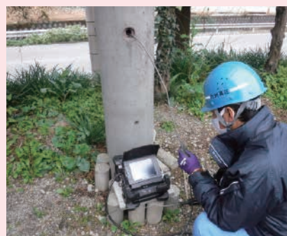
内部状況調査(ファイバースコープ)
