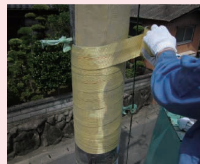
繊維シート補修工法
