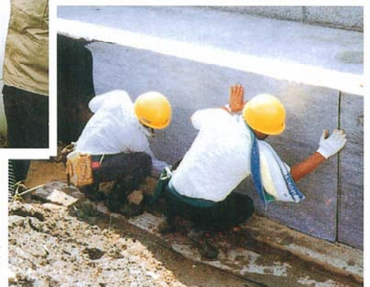
さいたま市大宮地区 ソニックシティビル地下外壁SLシート貼付
