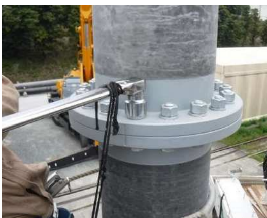
プリセツトルクレンチによる一次締め
