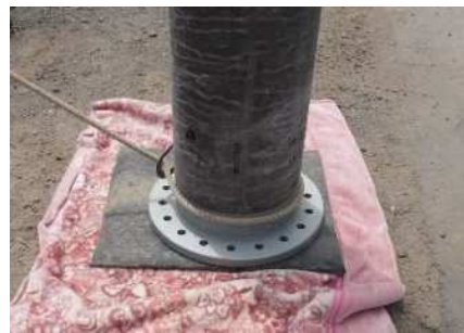
ゴムマットによるコン柱端部の保護
