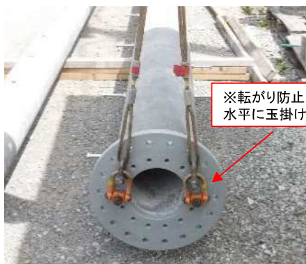
吊治具による吊り上げ (最上部の部材以外の吊り上げ例)
