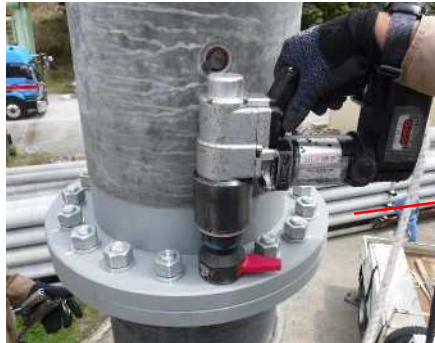
電動トルクレンチによる本締め
