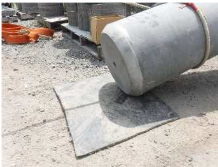
ゴムマットによるコン柱端部の保護
