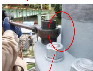
フランジ金具への工具の接触なし (キズは入らない)
