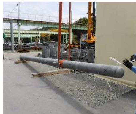
ナイロンスリングによる吊り上げ (最上部の部材の吊り上げ例)
