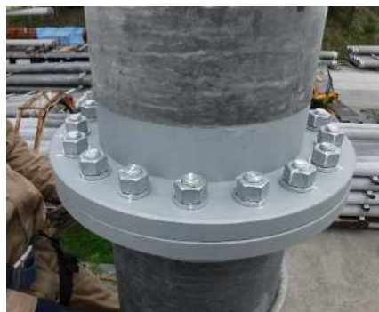
本締め完了 (マーキング角度全数確認)
