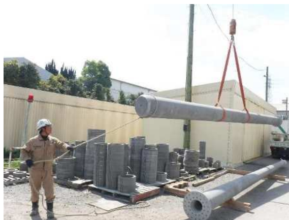
荷降ろし状況 (縄ロープによる振れ防止)
