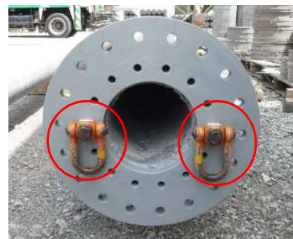
吊治具取付状況(参考)
