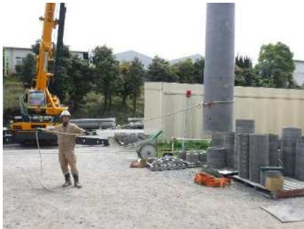
縄ロープによるコン柱の誘導
