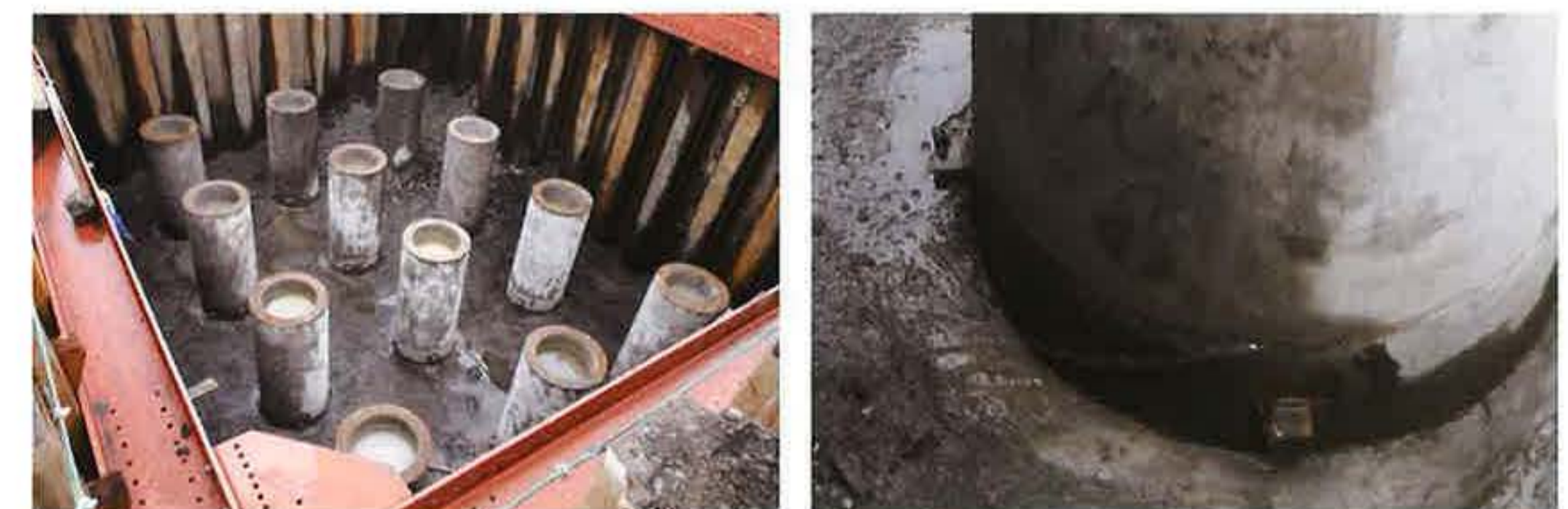
施工後の杭頭部掘削状況
