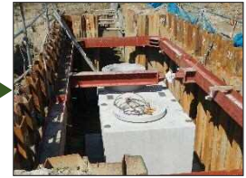
[マンホール設置工事]
